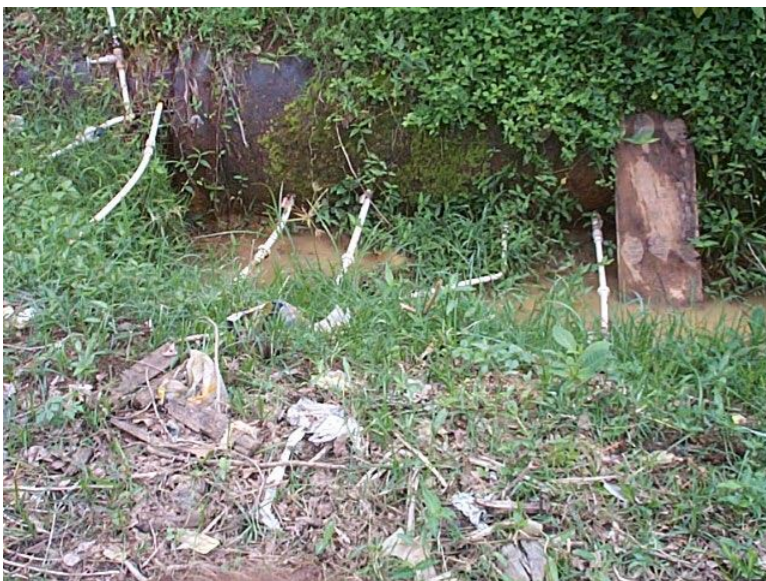
FLAGRANTE DE LIGAÇÕES CLANDESTINAS EM ADUTORA
